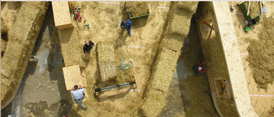
Baustelle mit Werner Schmidt. Ferienwohnungen am Esser Hof in Lana, Italien
