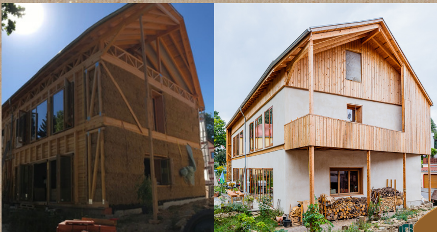
Lasttragendes Mehrfamilienhaus. Architekt: Florian Hoppe
